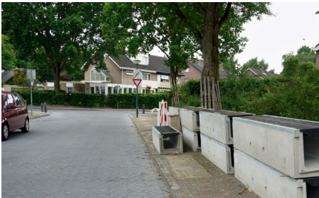
Figuur 2.11 Aanleg roostergoten.
