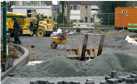
Figuur 2.9 Aanleg doorlatende en bergende verharding (Aquaflow).
