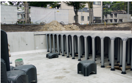
Figuur 2.10 Aanleg bergingskelders (Waterblock).
